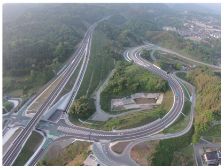
山陰道浜田港インターチェンジ
